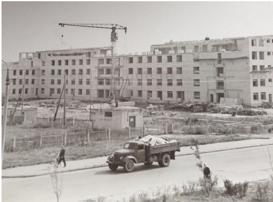
Рис. 4. Строительство нового корпуса стационара. 1966 г.
